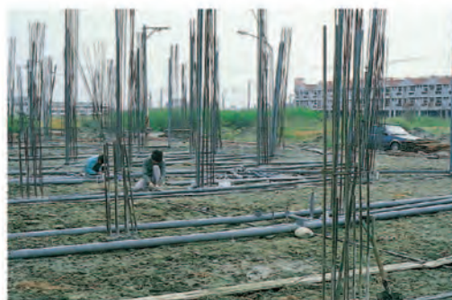
▲建筑工程 Construction engineering
