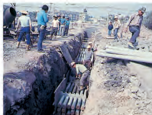
▲ 电气工程 Electrical engineering
